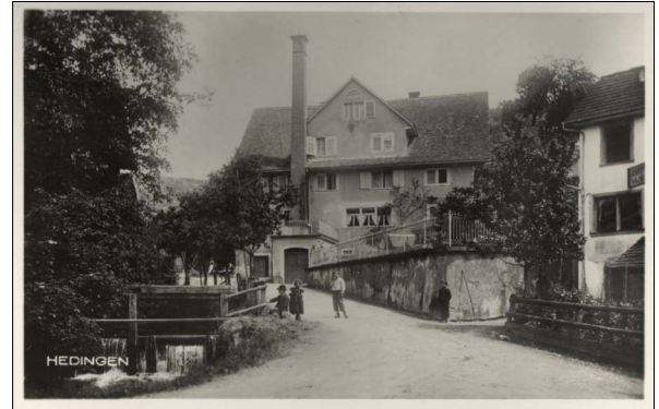
Im Haus «zur Mühle» (hier um 1928) befand sich die erste Schreinerverkstatt.
